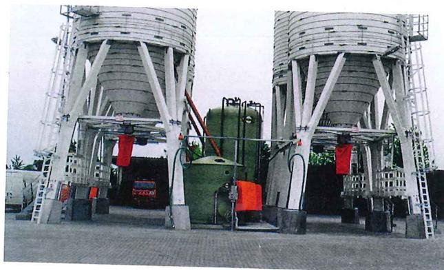
Bild 2: Moderne Kompaktanlage mit Salzsilos, Lösungstank und Soleerzeuger, der direkt aus einem Silo mit Salz beschickt wird (Foto: Stadt Leipzig)
