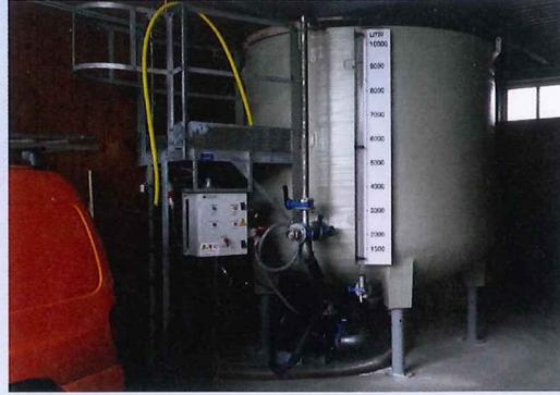
Bild 4: Schnelllöseanlage Speed-Brine bei der Stadt Fürstentfeldbruck, befüllbar direkt aus dem in der Halle integrierten Silo oder per Big Packs
