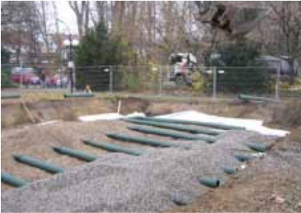
Abb. 7: Mulden-Rigolen-System im Bau
