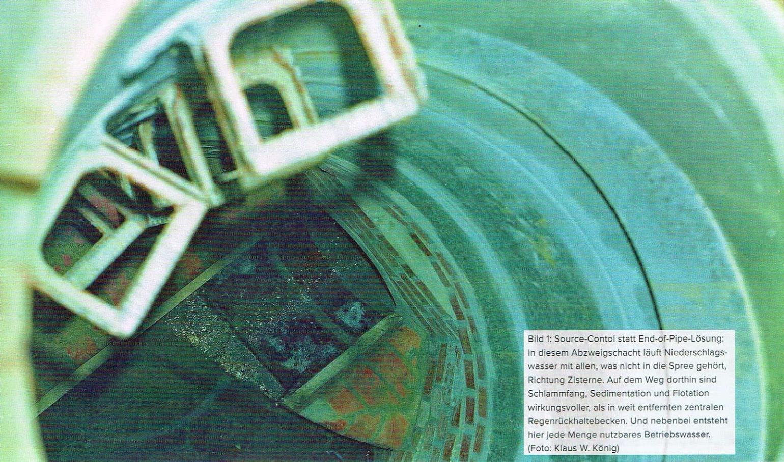
Bild 1: Source-Contol statt End-of-Pipe-Lösung: In diesem Abzweigschacht läuft Niederschlagswasser mit allen, was nicht in die Spree gehört, Richtung Zisterne. Auf dem Weg dorthin sind Schlammfang, Sedimentation und Flotation wirkungsvoller, als in weit entfernten zentralen Regenrückhaltebecken. Und nebenbei entsteht hier jede Menge nutzbares Betriebswasser. (Foto: Klaus W. König)
