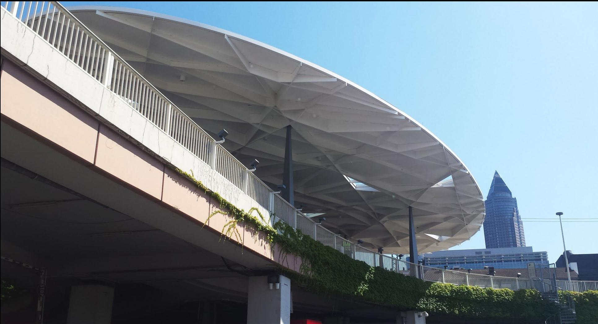
Ein ovaler Trägerrost aus statisch optimierten Stahlblechen mit 150 bis 600 mm Bauhöhe. Er liegt auf 4 (kontextbedingt) unregelmäßig angeordneten eingespannten Stützen.
