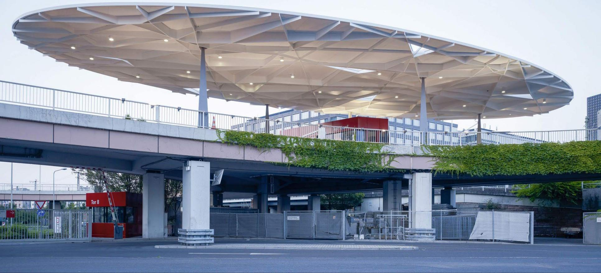
Ein ovaler Trägerrost aus statisch optimierten Stahlblechen mit 150 bis 600 mm Bauhöhe. Er liegt auf 4 (kontextbedingt) unregelmäßig angeordneten eingespannten Stützen.
