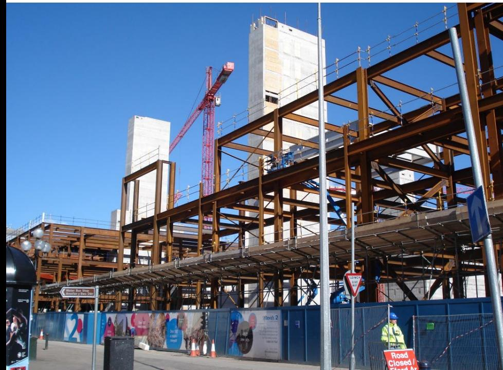
Weil beim Stahlskelettbau naturgemäß die tragenden Bauteile im Werk vorgefertigt und anschließend zur Bausteile transportiert und montiert werden, sie werden nicht dort erzeugt, ist ein hoher Vorfertigungsgrad möglich und es können kurze Bauzeiten angestrebt werden.
