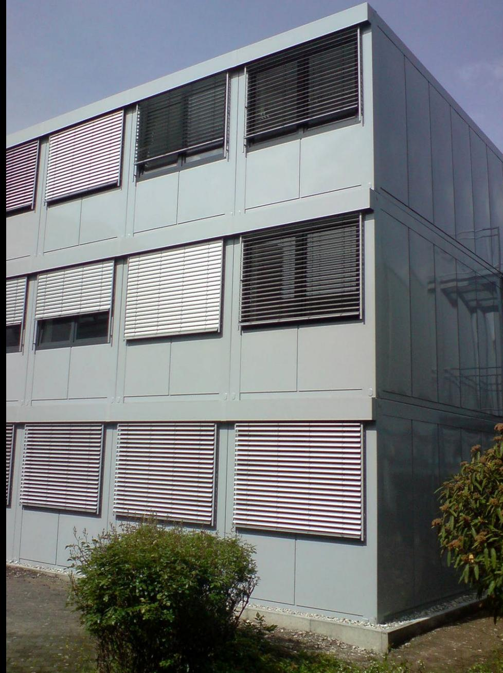
Die Abmessungen der Zellen sind dabei abhängig von der Bauaufgabe, den Transportmöglichkeiten und dem Bausystem. Die regulären Maße liegen bei 3 m x 8 m, maximal sind Abmessungen von 6 m x 20 m möglich. Die Höhe der Raummodule beträgt 3,2 m bis 3,7 m.
