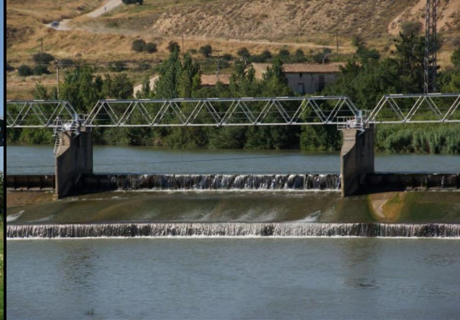
Eine Besonderheit stellt der sogenannte Warren-Träger dar, der im 19. Jahrhundert erfunden wurde. Charakteristisch sind die dreieckig angeordneten Diagonalen ohne vertikale Druckstäbe.
