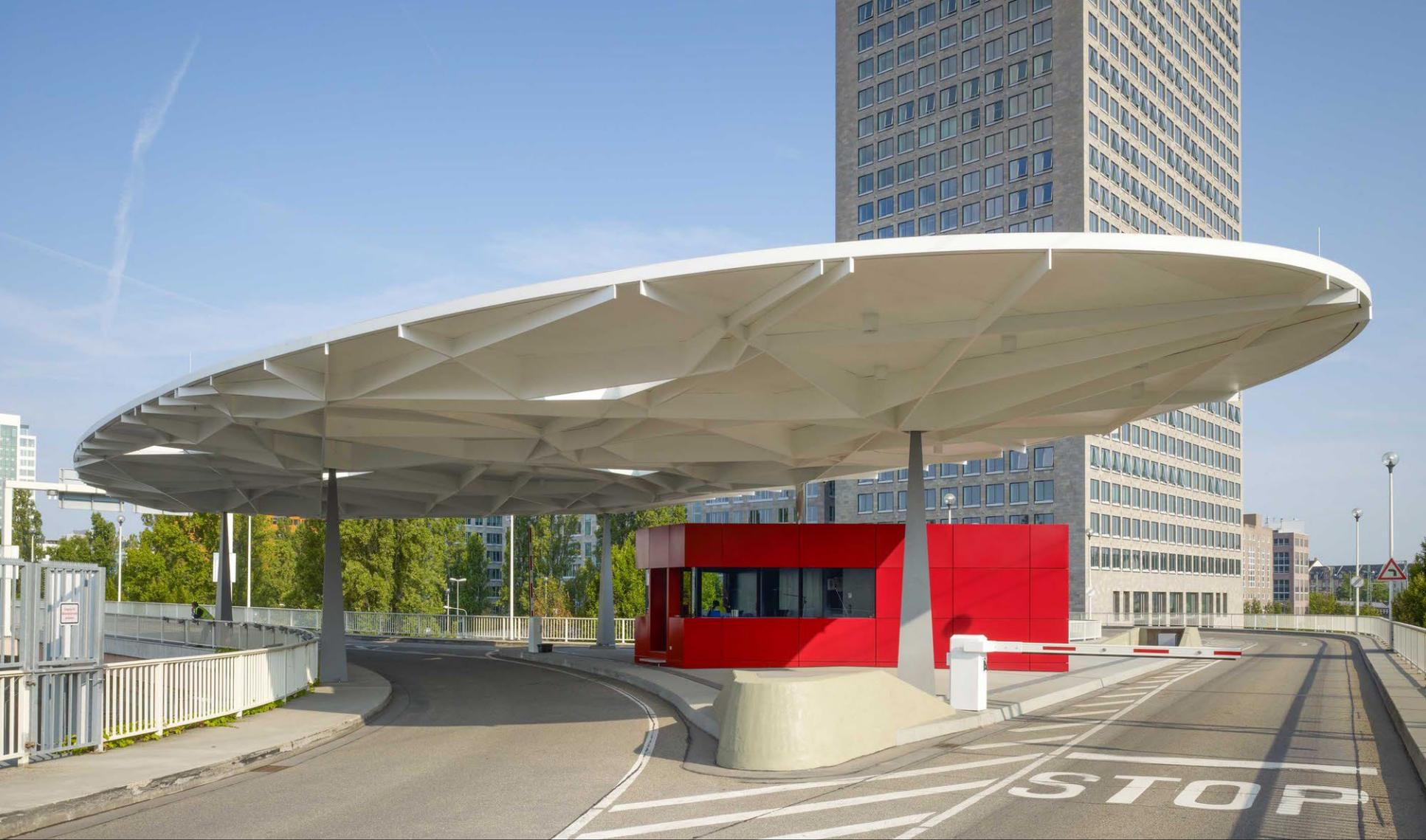
Ein ovaler Trägerrost aus statisch optimierten Stahlblechen mit 150 bis 600 mm Bauhöhe. Er liegt auf 4 (kontextbedingt) unregelmäßig angeordneten eingespannten Stützen.
