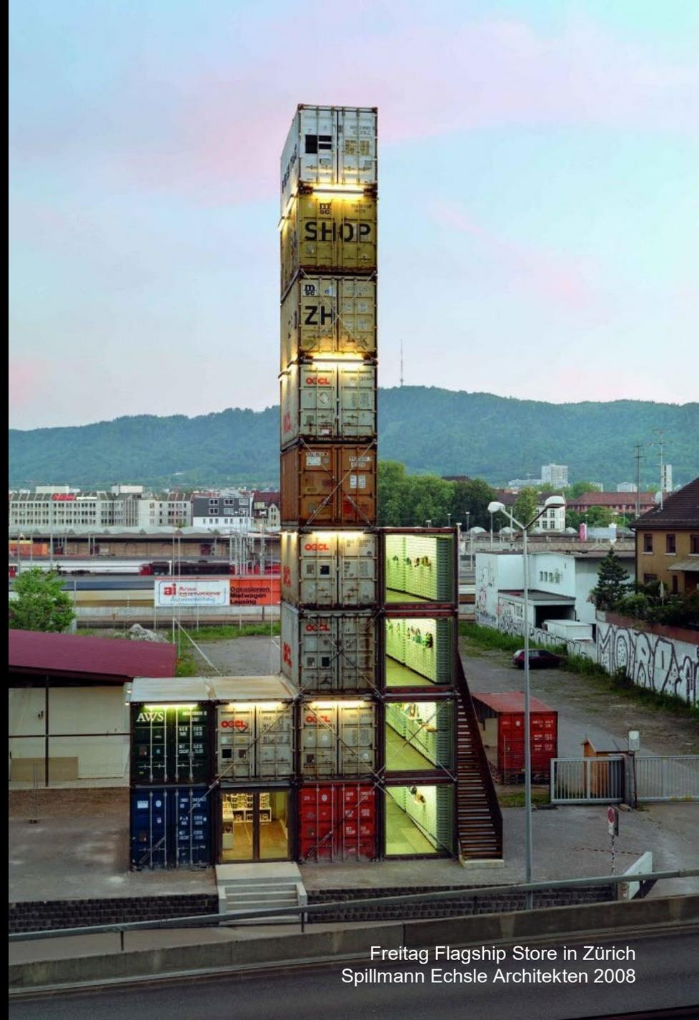
Dabei wurden 17 Transportcontainer als *Objet trouvé* provisorisch aufgestellt und mit einer herkömmlichen Transportverbindung „Quick-Tie TV/ Tricon“ (nicht der übliche Twistlock Drehverschluss) gesichert.
