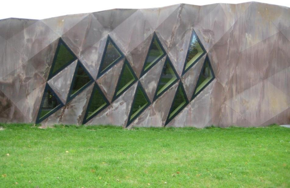
3000 CNC-gefräste dreieckige Cortenstahlplatten, die in 12 Teilen vormontiert geliefert und vor Ort zu einem Faltnetz verschweißt wurden.
