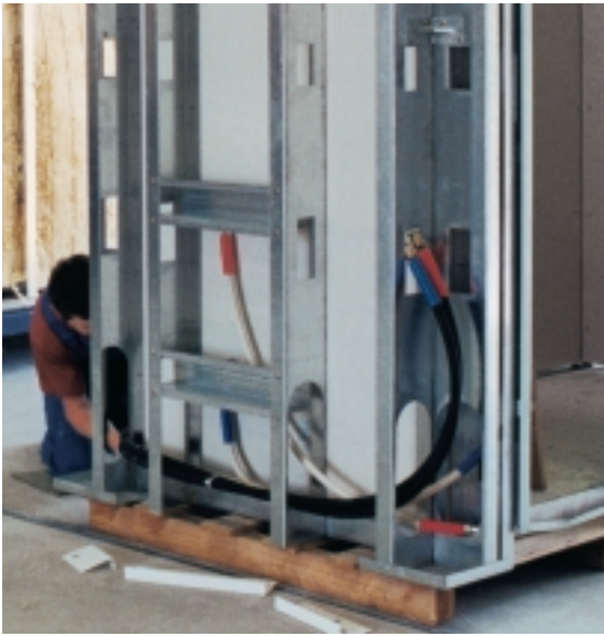
Abb. 28: Lochung von Leichtprofilen mit durchgeführten Installationen
