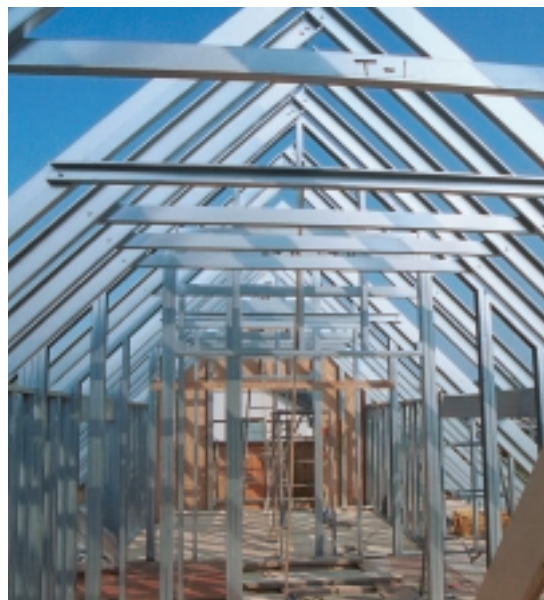
Abb. 10: Dachtragwerk eines Wohn- hauses aus kaltgeformten Stahlprofilen (The Japan Iron and Steel Feder- ation, Japan)
