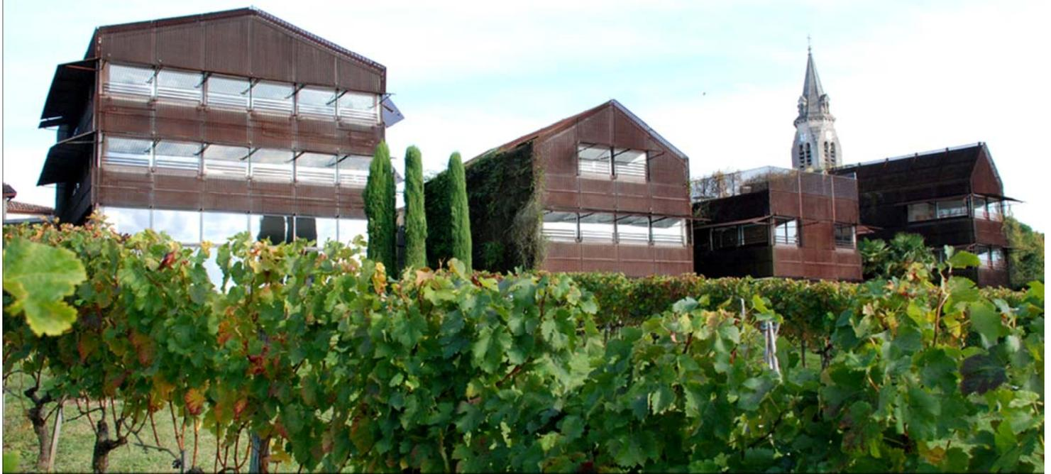
Ein „Klassiker“ von Jean Nouvel einer Fassadenbekleidung mit Gitterrosten aus Cortenstahl.
