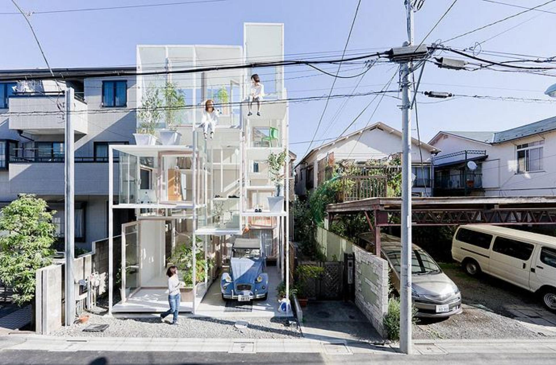
Bei Stahlskeletten handelt es sich in der Regel um Stabwerke aus linearen Bauteilen, die im Zusammenwirken mit Aussteifungselementen eine in sich stabile Konstruktion bilden. Tragende werden dabei von nichttragenden Elementen getrennt und die Anordnung wird in einem Raster organisiert.
