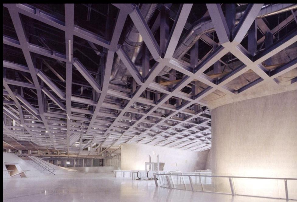
Zur optimalen Ausnutzung der Konstruktionshöhe sollten die höher belasteten Hauptträger über eine kürzere Spannweite reichen als die geringer belasteten Nebenträger.
