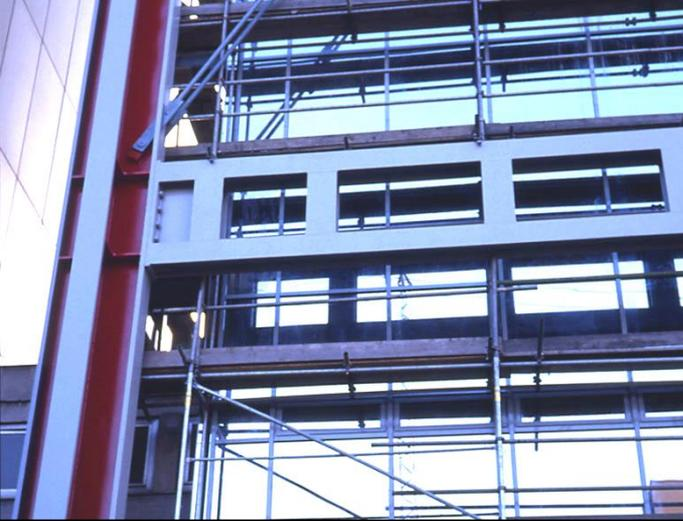
Mehrgeschoss-Tragwerksysteme aus Mehrfeld-Rahmen
