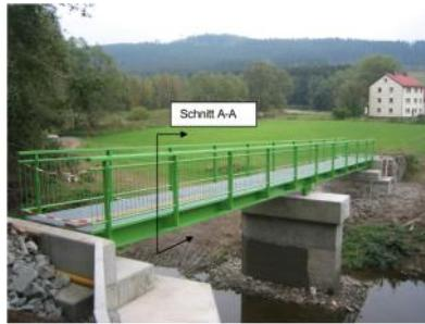
Die dargestellte Fußgängerbrücke spannt über zwei Felder mit je 5 m Spannweite. Sie besteht aus 2 Stahlträgern, auf denen Gitterroste aufliegen und an denen die Geländer befestigt sind. Der Abstand der Träger beträgt 2 m. Dies ist auch die ansteigende Brückenbreite.
