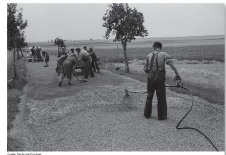
Bild C6: Straßenaufbau nach US-Patent von 1877 [M. Niggemann - Angewandter Straßenbau]
